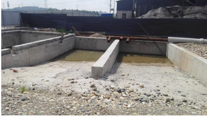
循环水沉淀池
