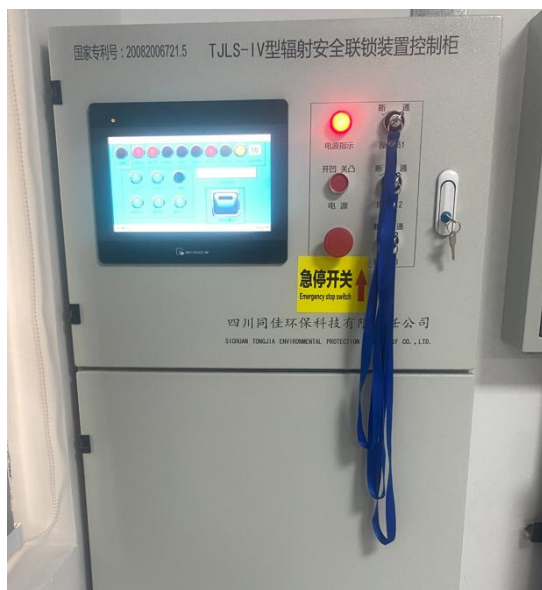
图 3-6 门机联锁控制系统
