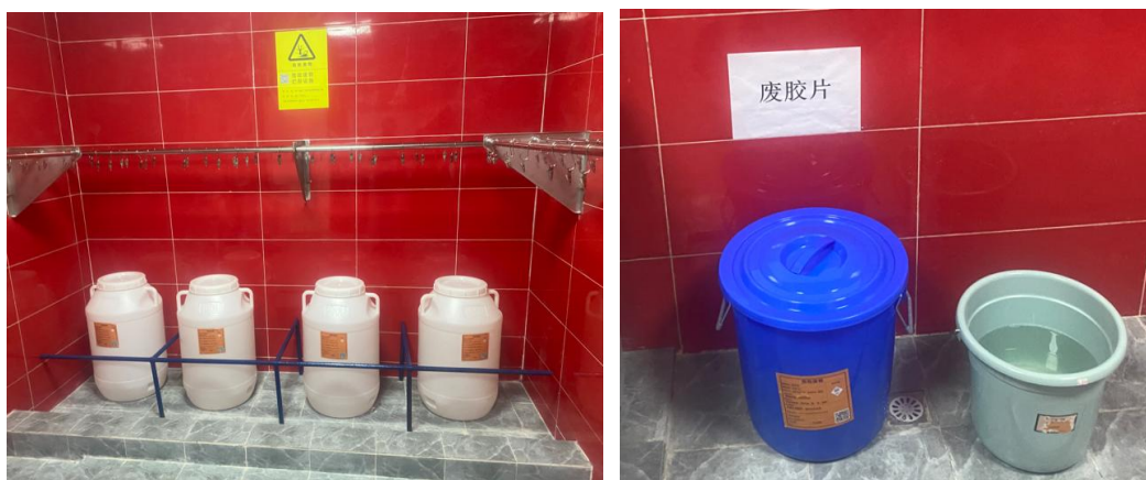
图3-17 危废暂存设施
